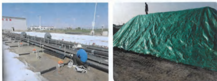
图 5.2-2 生物堆作业区
